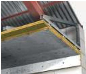
Las escuadras **INGEPERFIL** están especialmente diseñadas para ejecutar franjas de encuentro medianería-cubierta con el objetivo de retrasar o impedir la propagación del fuego entre dos naves industriales contiguas o sectores de incendio a través de la cubierta.
