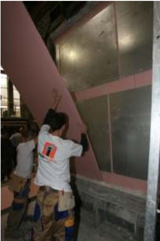
Figura 1. Montaje de la "Chapa Antivandálica" entre dos placas PYL
