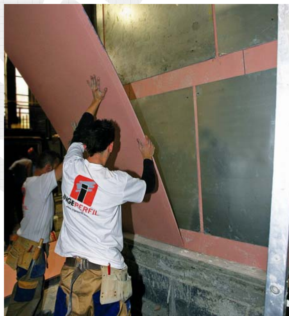
Figura 1. Montaje de la “Chapa Antivandálica” entre dos placas P.Y.L.
